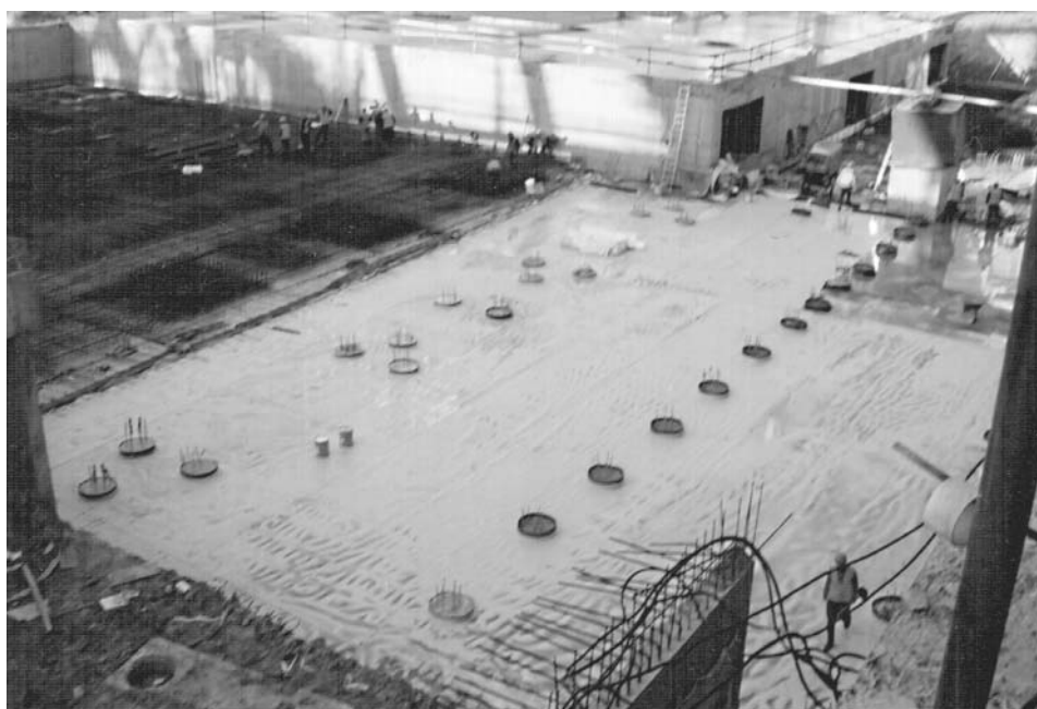
Рис. 1. Внешний вид гидроизоляции днища
